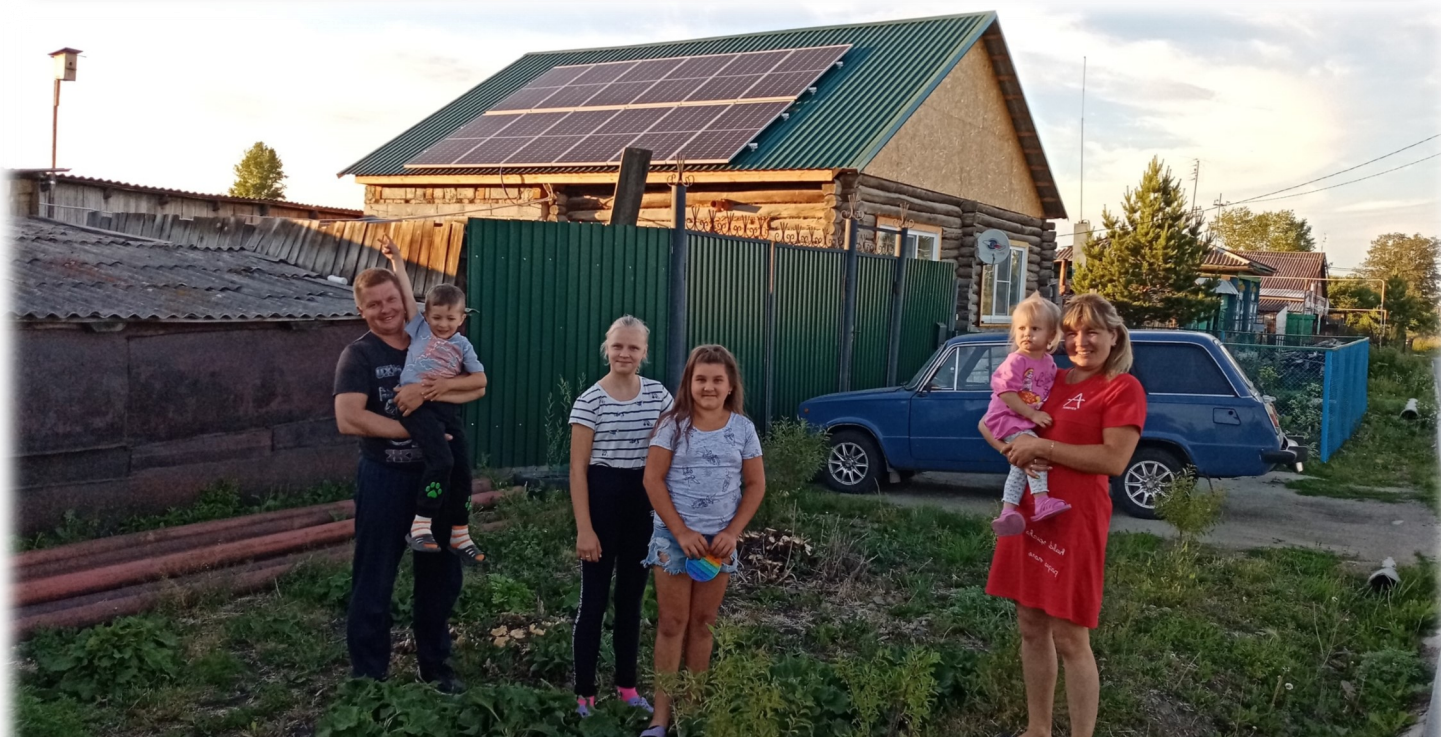
Большая дружная семья Нагаткиных из села Бродокалмак стала участниками проекта «Солнечная энергия». На крыше их дома установлены солнечные батареи, с помощью которых можно получать электричество.
